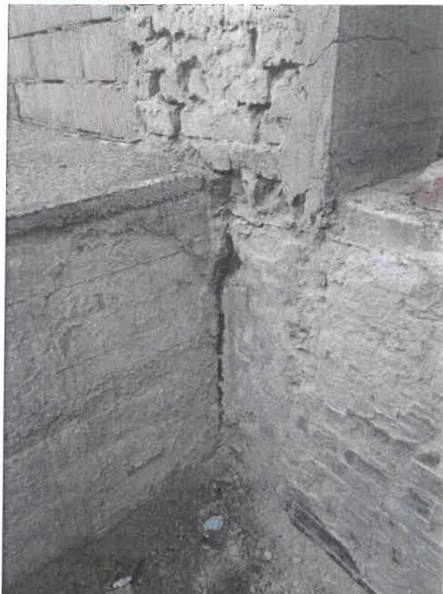
- prasklina ve vnitřní části (vstup do 1. PP)
