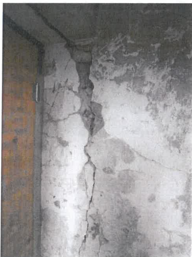
- prasklina ve vnitřní části (vstup do 1. PP)
