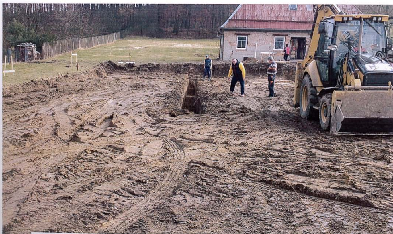
SKRÝVKA ORNICE A ZALOŽENÍ OBJEKTU
