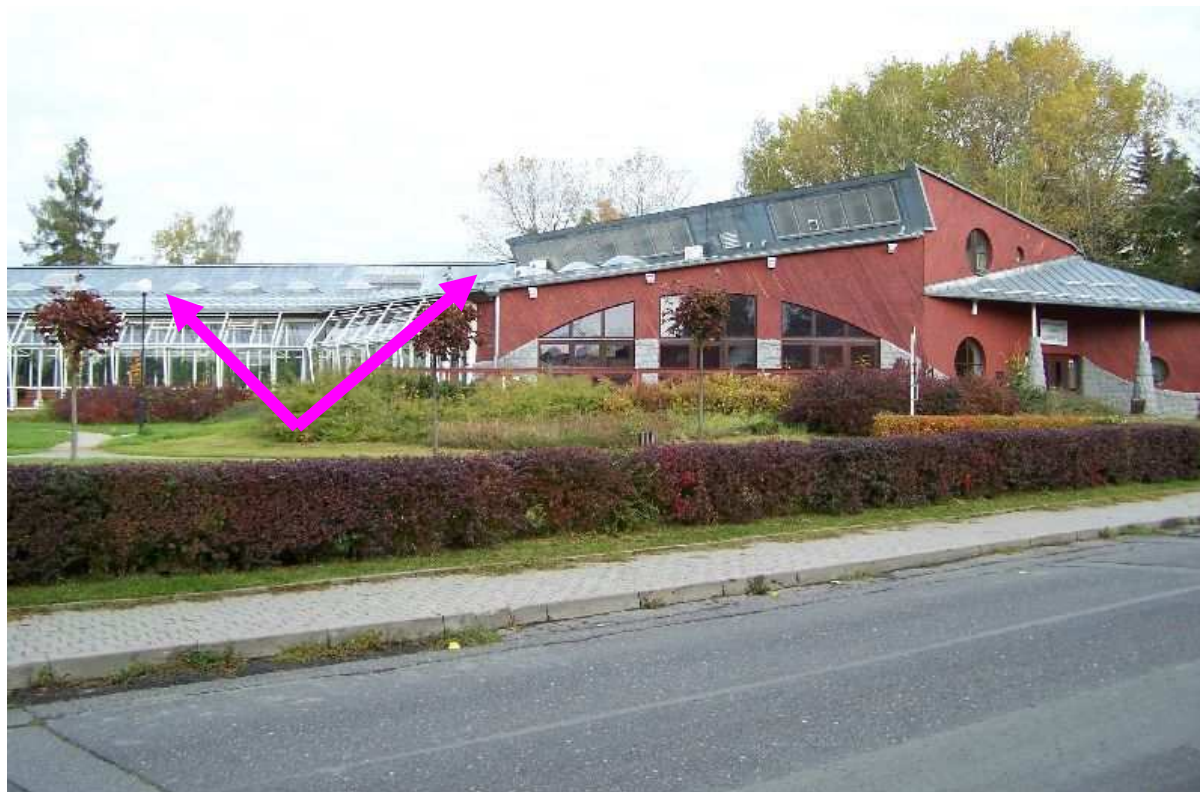
Obrázek 3 Pohled z jihovýchodu (šipkou označeno místo instalace kolektorů)
