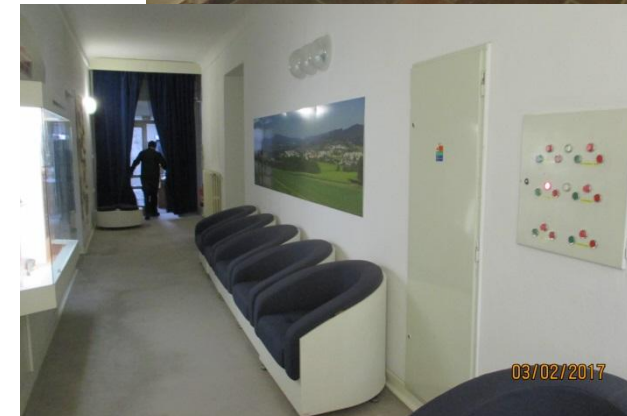
Foto: typický patrový el. rozvaděč a ovládací skříň osvětlení výstavních prostor
