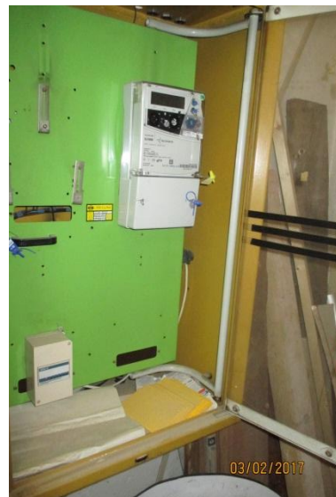
Foto : fakturační měření celého objektu zámku Kinských, umístěné v el. rozvaděči ER
