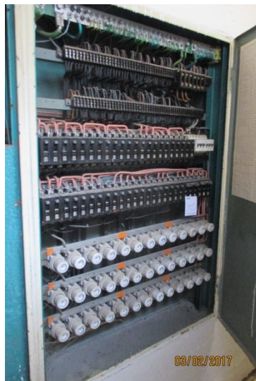
Foto: podružné měření pro byt umístěné v el. rozvaděči HR
