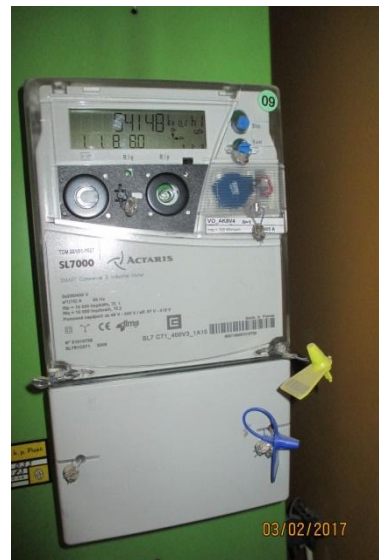
Foto : fakturační měření celého objektu zámku Kinských, umístěné v el. rozvaděči ER
