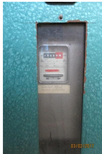
Foto: podružné měření pro byt umístěné v el. rozvaděči HR
