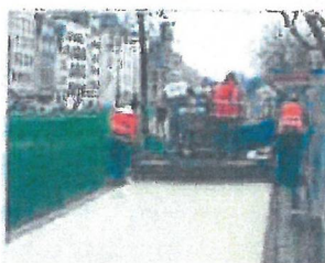
Stavba cesty v parku
