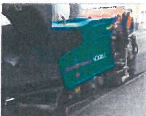
Asfaltová cesta v tramvajové kolejnici
