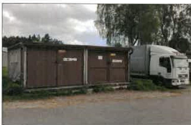
IZOMAT - bývalý sklad chemikálií
