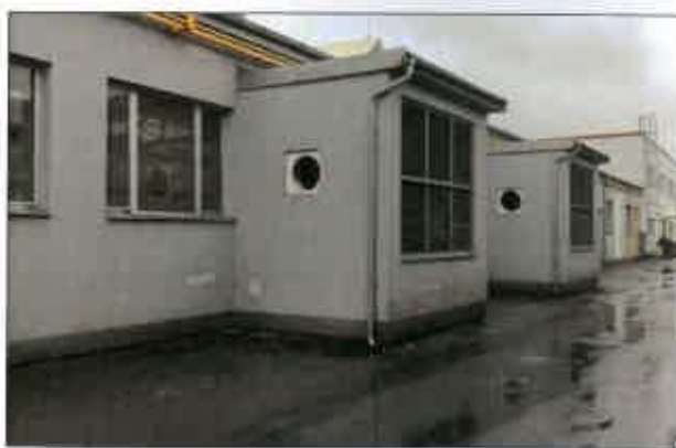
KOVOTEX/ELITEX/ELITECHNICS - prostor bývalé lakovny a odmašťovny
