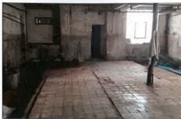
Areál Galček - interiér bývalé galvanovny
