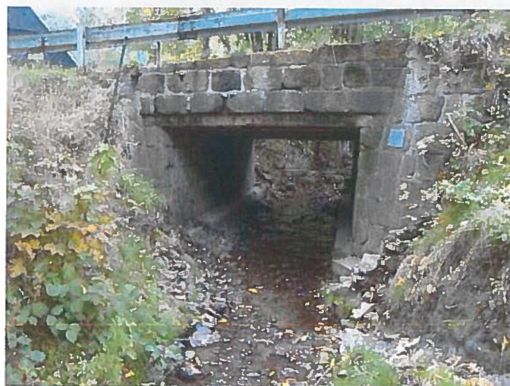
Pravá výtoková stran mostu
