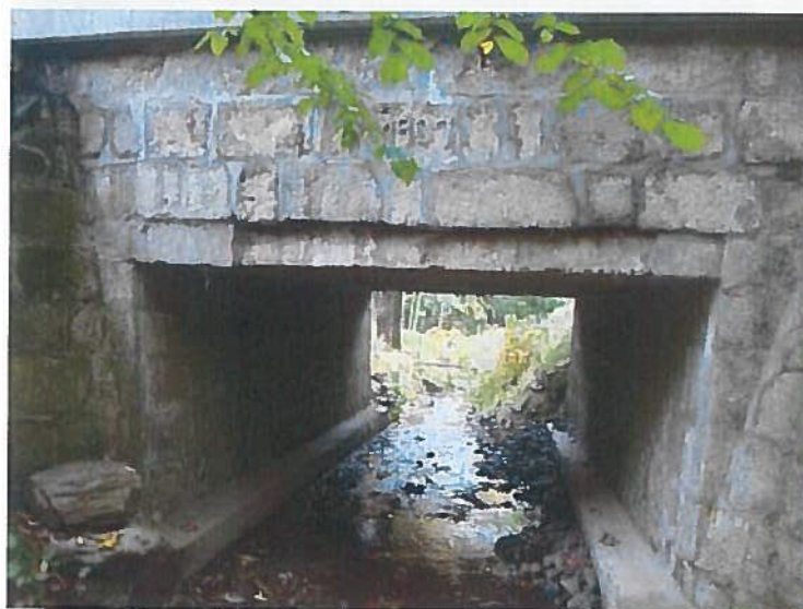
Levá vtoková strana mostu
