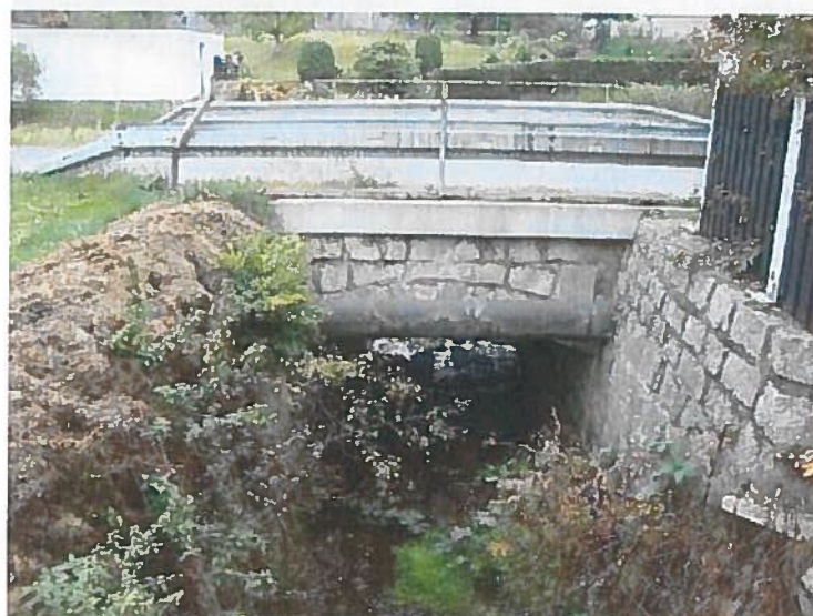
Levá vtoková strana mostu
