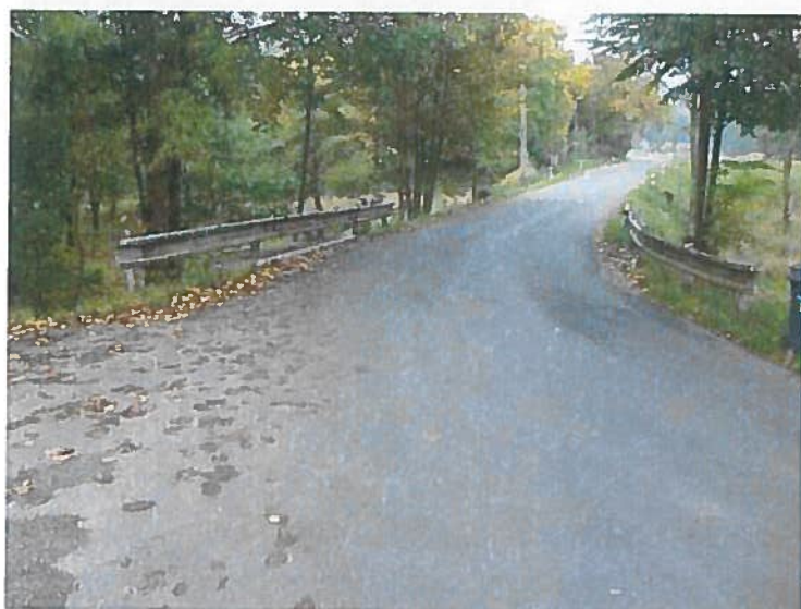
Pohled po směru staničení
