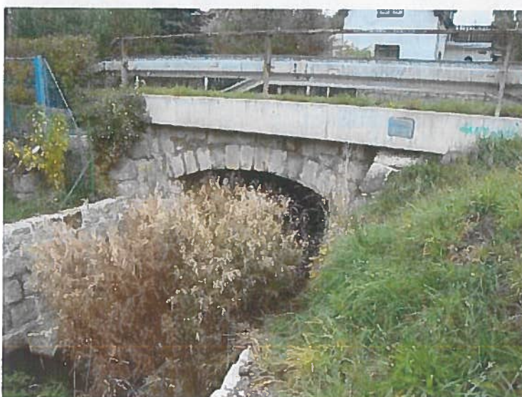
Pravá výtoková strana mostu
