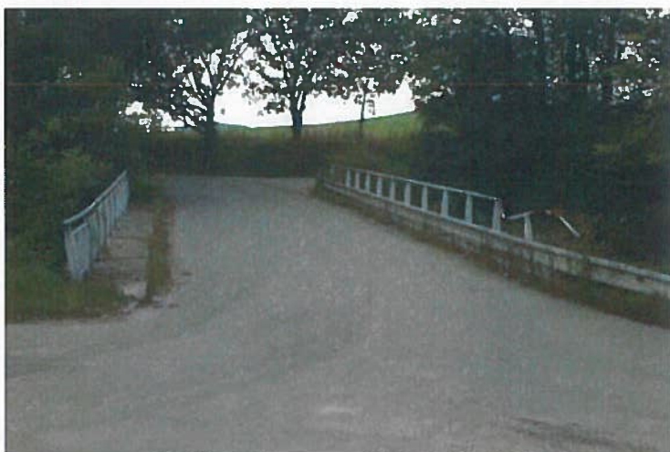
Pohled proti staničení
