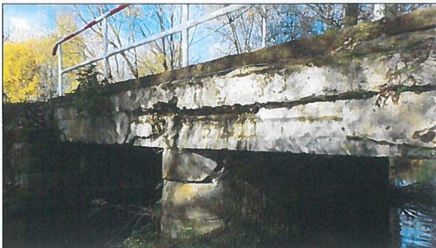
Degradace betonu římsy, uchycená vegetace, trhlina na PI na pravé straně
