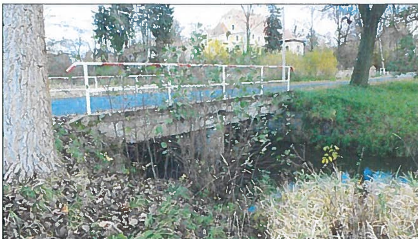
Pohled na pravou stranu konstrukce
