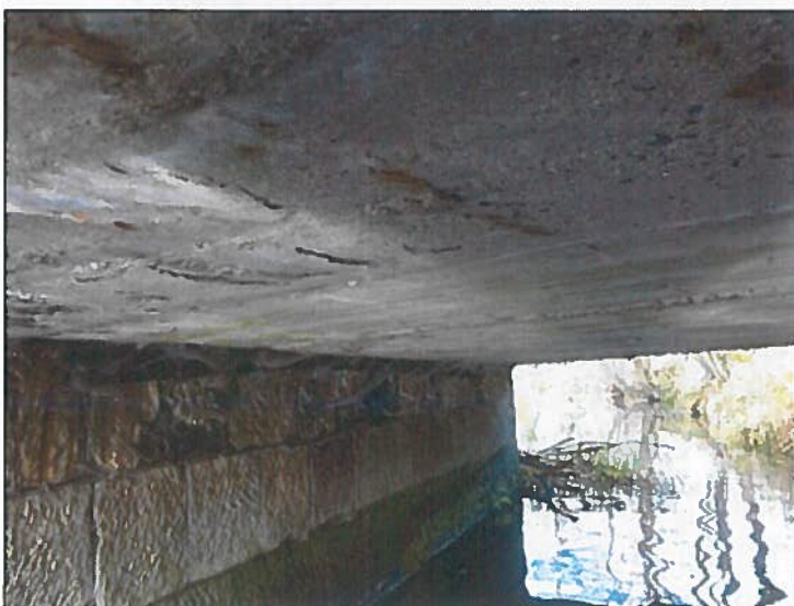
Podhled NK pole2
