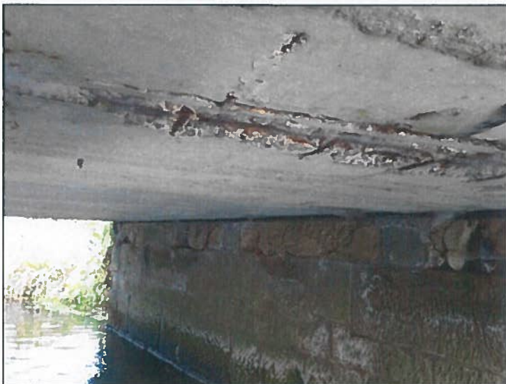
Podhled NK pole1
