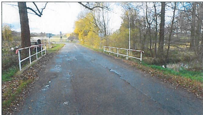
Celkový pohled proti směru staničení
