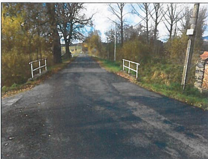
Celkový pohled proti směru staničení
