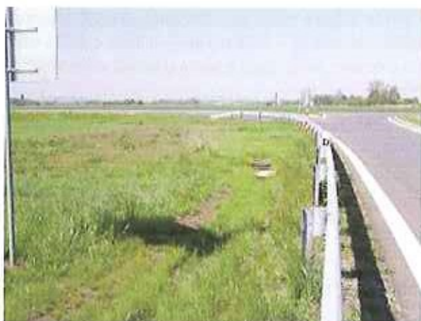
Detail levé krajnice a příkopu
