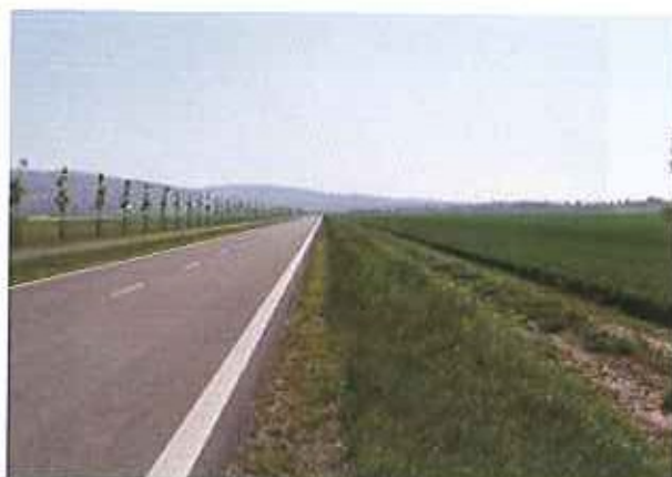
Komunikace Východ – detail pravé krajnice
