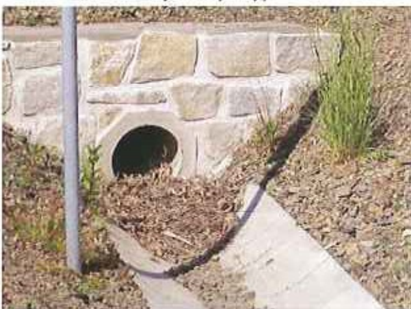
Detail zaneseného propustku
