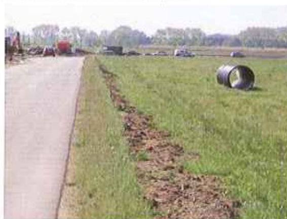
Objízdňá komunikace – pravá krajnice
