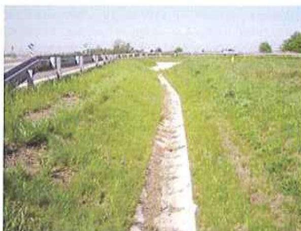
Detail pravé krajnice a příkopu
