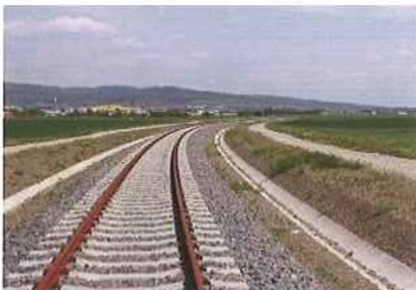
Těleso vlečky a oba příkopy
