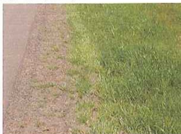
Detail pravé krajnice
