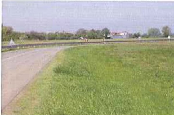
Detail svahu podél objízdňé komunikace
