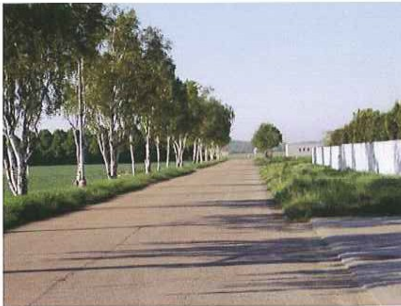
Příjezdová komunikace Tovární
