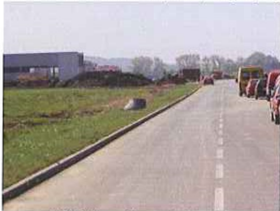
Objízdňá komunikace – levá krajnice
