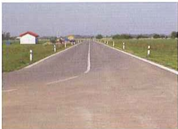
Příjezdová komunikace „Západ“
