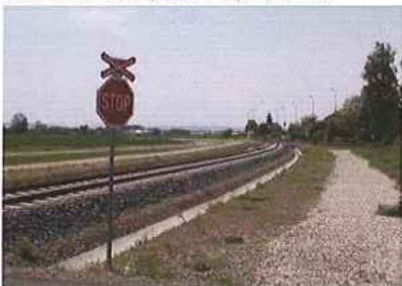
Násep a odvodnění železniční vlečky
