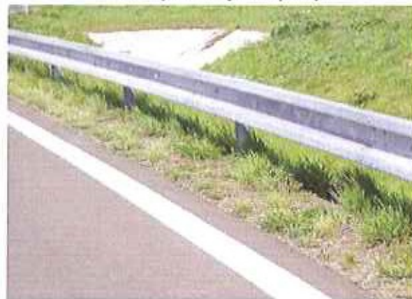
Detail pravé krajnice a svodidla
