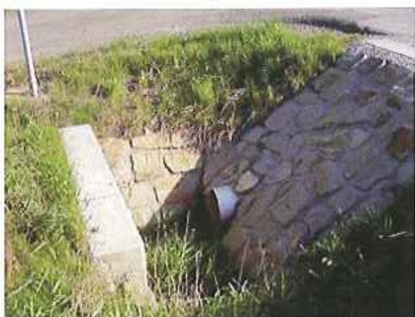
Cyklostezka směr Holešov – detail zanesených propustků
