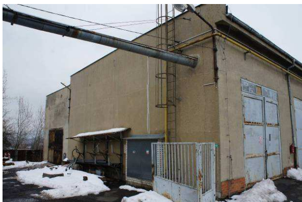
Obrázek 8: Pohled na Z fasádu.
