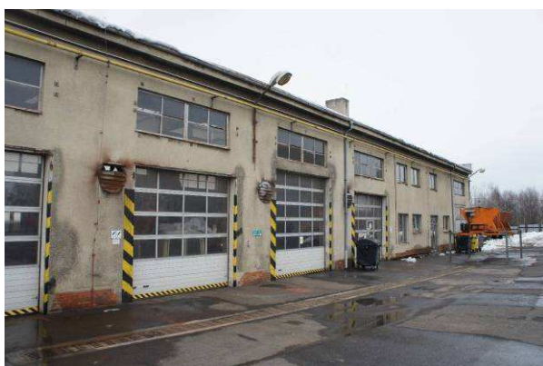
Obrázek 6: Pohled na budovu J fasádu – pravá část.
