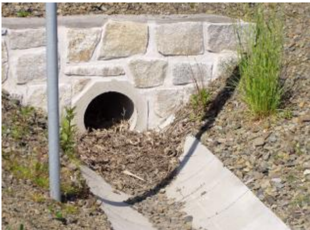
Detail zaneseného propustku
