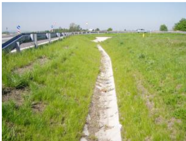
Detail pravé krajnice a příkopu
