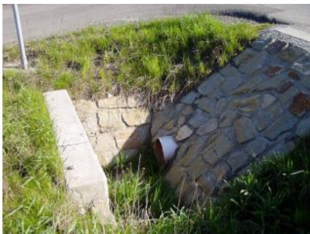
Cyklostezka směr Holešov – detail zanesených propustků
