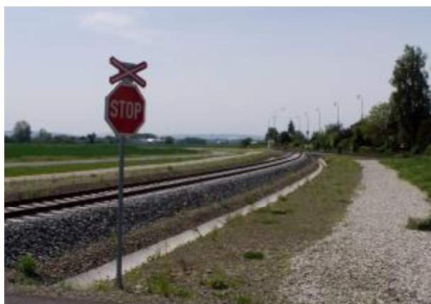
Násep a odvodnění železniční vlečky
