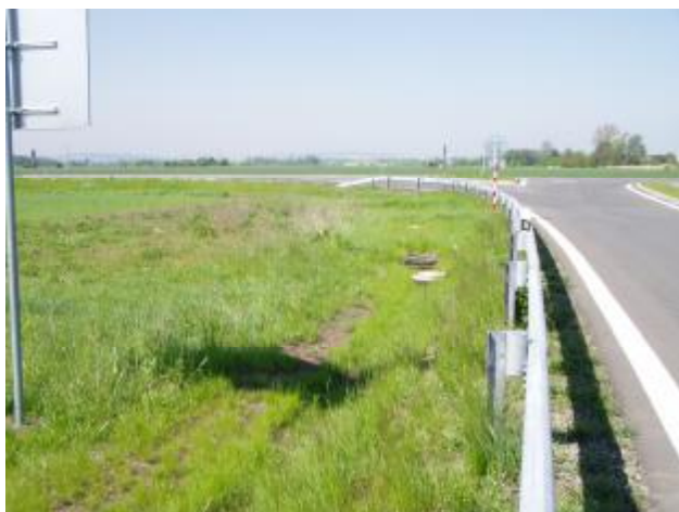
Detail levé krajnice a příkopu
