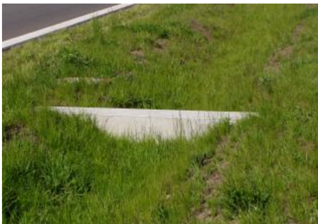
Komunikace Východ – průleh, detail zeleně
