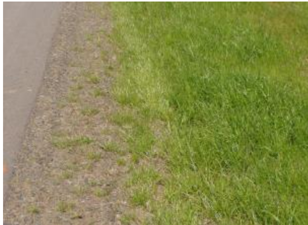
Detail pravé krajnice
