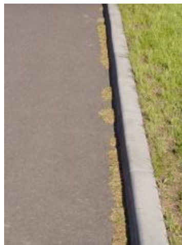
nečistoty podél krajnice
