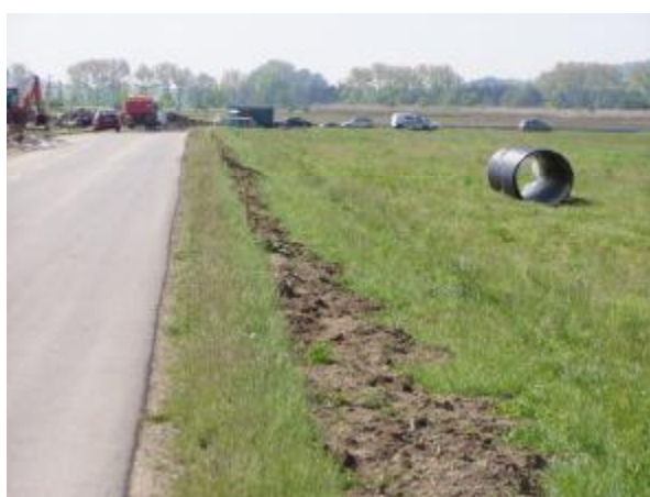
Objízdňá komunikace – pravá krajnice
