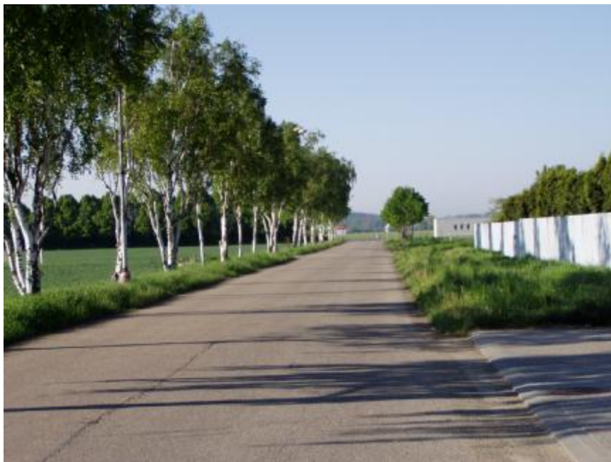
Příjezdová komunikace Tovární
