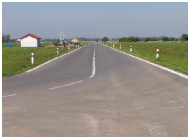
Příjezdová komunikace „Západ“
