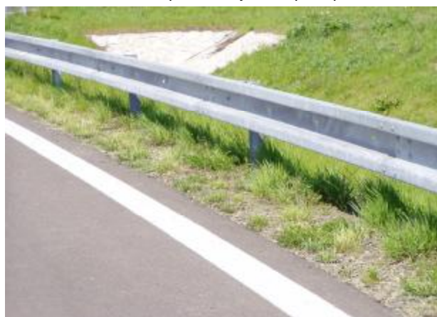
Detail pravé krajnice a svodidla
