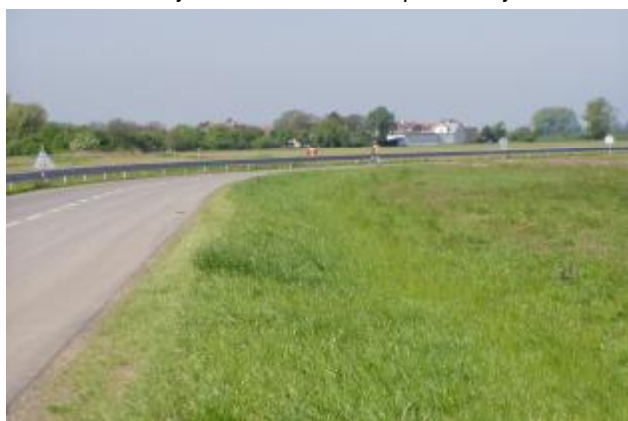
Detail svahu podél objízdňé komunikace
