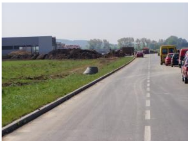
Objízdňá komunikace – levá krajnice
