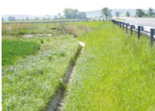
Detail odvodňovacího příkopu
