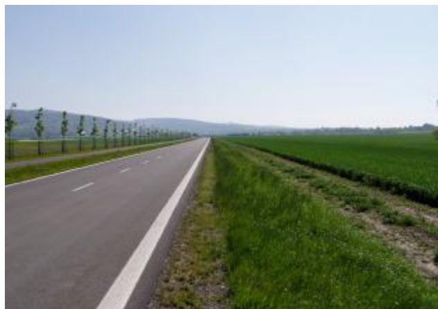
Komunikace Východ – detail pravé krajnice
