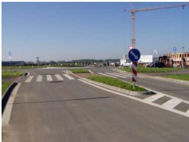
Vnitřní kruhová křižovatka – příjezd od Tovární
