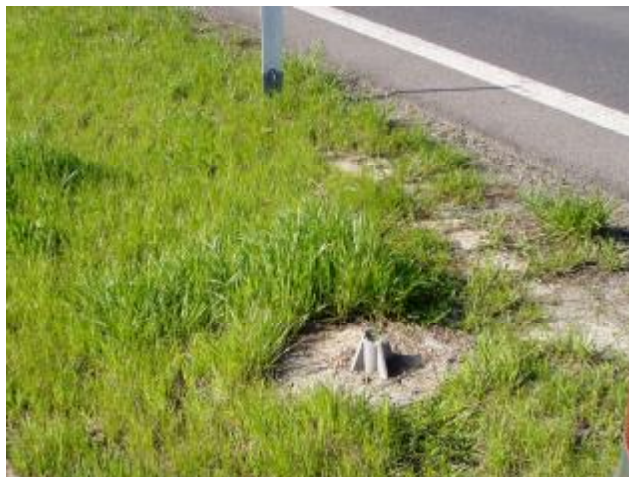
Cyklostezka směr Martinice - detail zaneseného propustku a poškozeného značení
