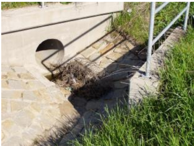
Cyklostezka směr Martinice - detail zaneseného propustku a poškozeného značení
