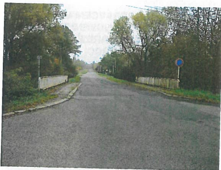
Pohled proti směru staničení
