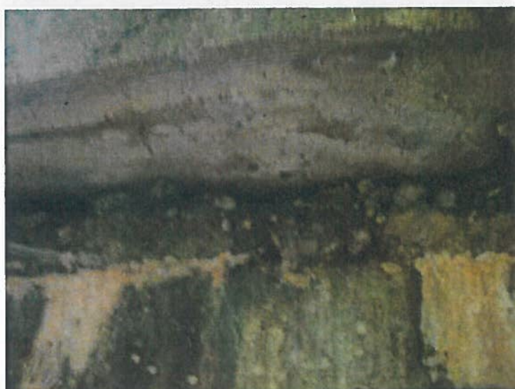
Degradace betonu pod prefabrikovanými římsami, zatékání na bok NK
