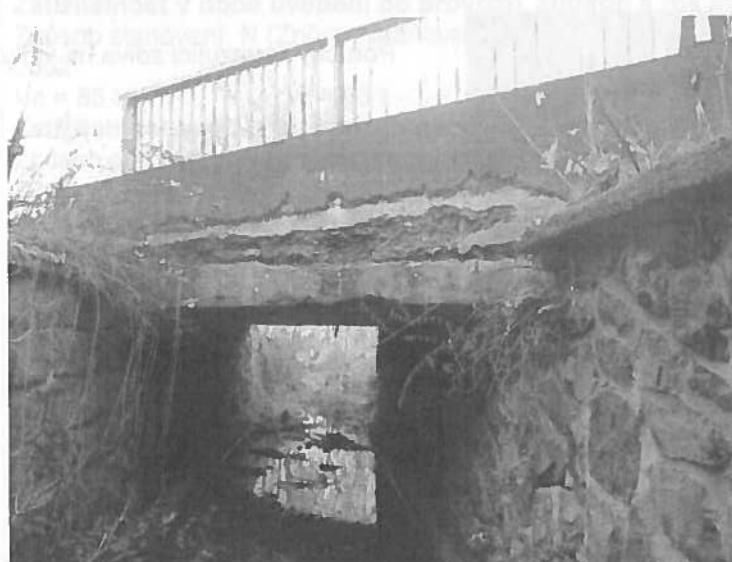
Pohled na vtokovou stranu objektu
