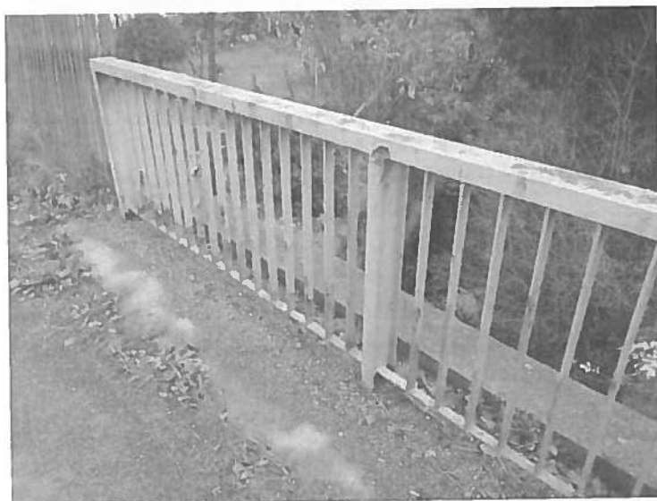
Uspořádání na vtokové římse
