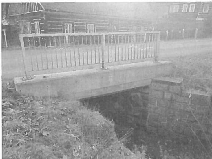
Pohled na výtokovou stranu objektu
