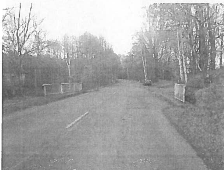
Pohled po směru staničení.
