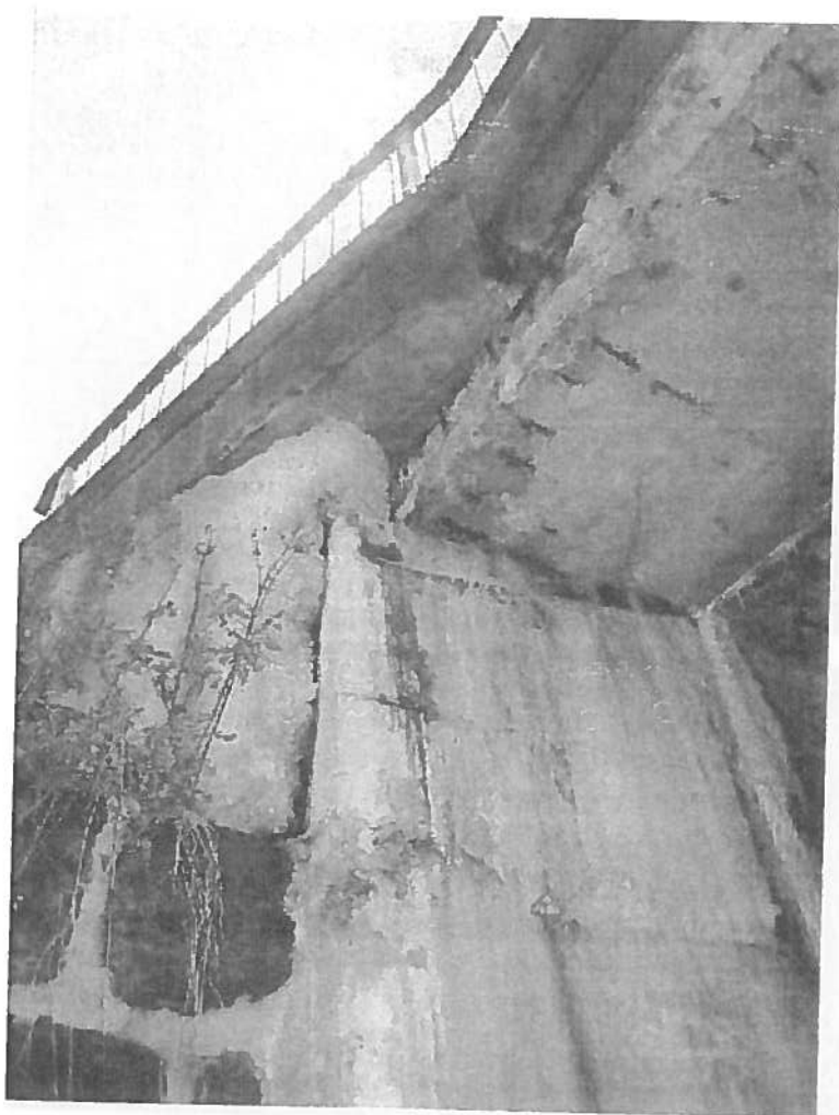
OP 2 - zatékání a prahy, zatékání do spáry NK, koroze výztuže NK i na bocích NK
