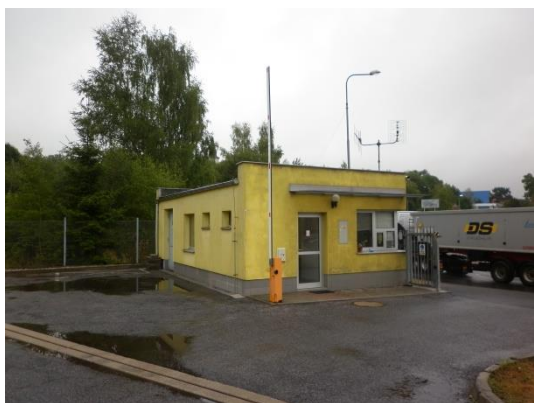
foto č. 26 – budova vrátnice
