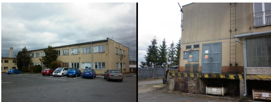
foto č. 3 a 4 – administrativní budova v areálu (vlastnictví cizího subjektu); v zadní části budovy prostor trafostanice
