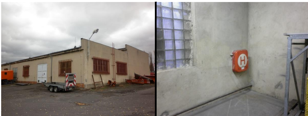
foto č. 12 a 13 – budova skladu a garáží; nástěnný hydrant v budově (pč. 451/4)
