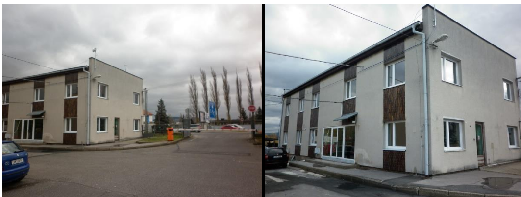
foto č. 1 a 2 – hl. vjezd do areálu s administrativní budovou (vnitřní prostory budovy v současné době v rekonstrukci)
