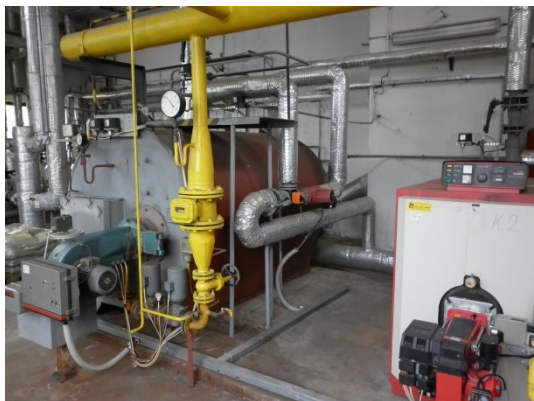
foto č. 7 – vnitřní prostor kotelny (PML)
