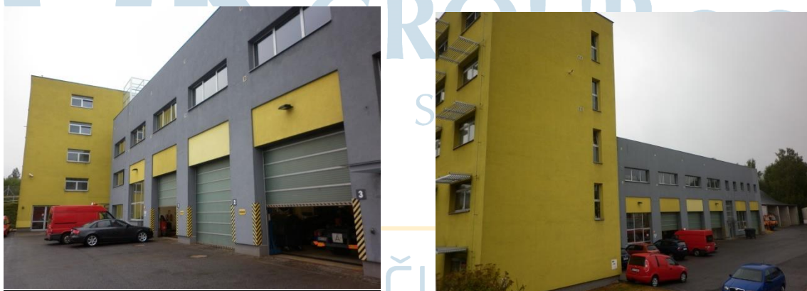
foto č. 18 a 19 – administrativní budova s garážemi a skladem olejů
