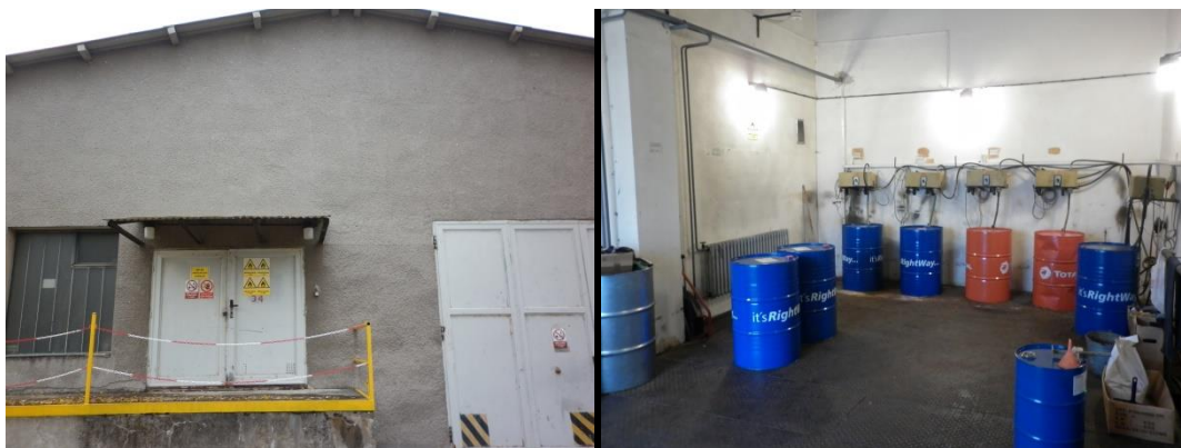
foto č. 16 a 17 – budova skladu olejů a dílny údržby; vnitřní prostory skladu olejů (pč. 451/18)
