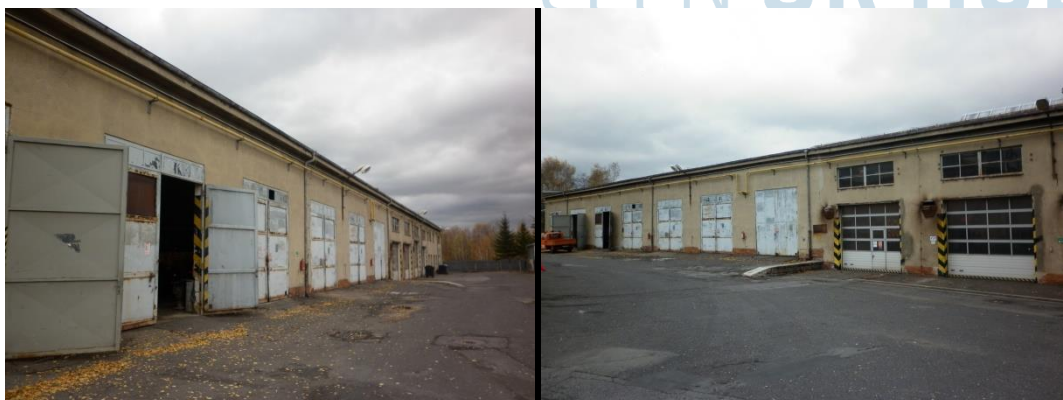
foto č. 5 a 6 – hala dílen, garáží a kotelny (PML)
