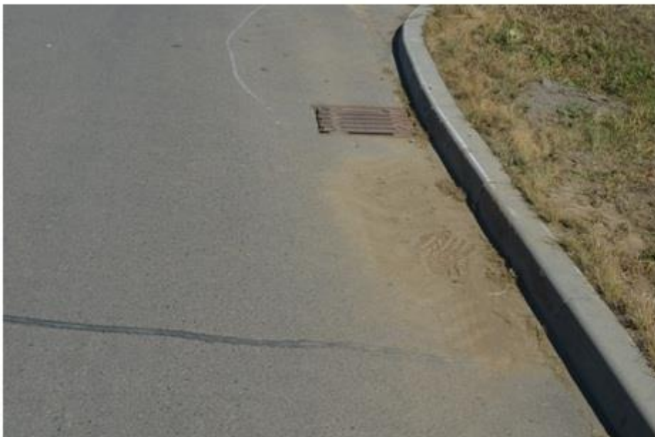
Dešťová kanalizace – silniční vpustí
