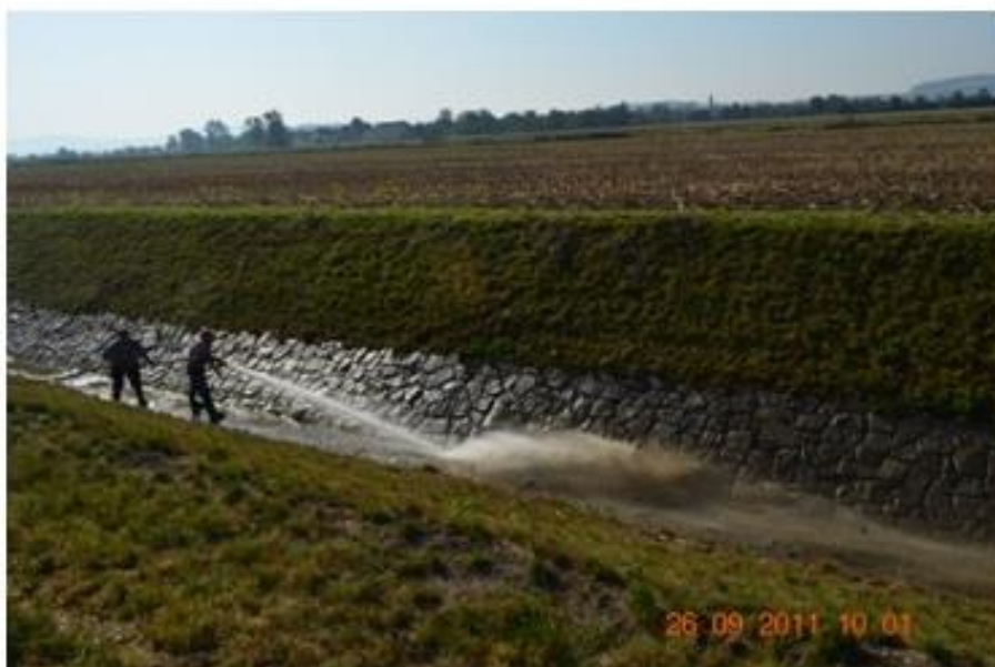
čistění KDV tlakovou vodou
