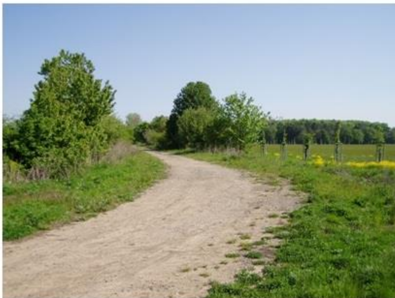
Účelová komunikace k sídlišti
