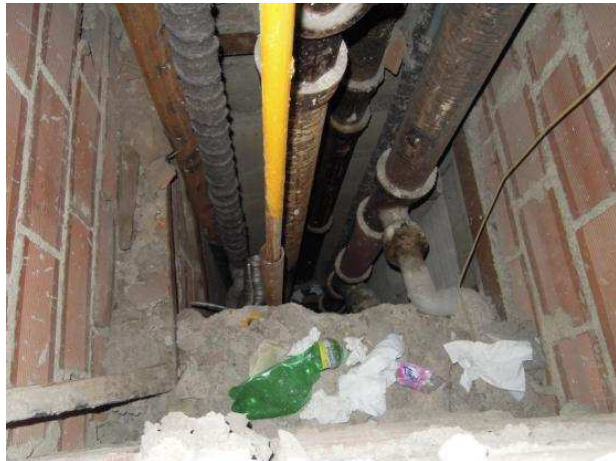
Instalační jádro ZTI v strojovně VZT-foto 7.np podlaha
