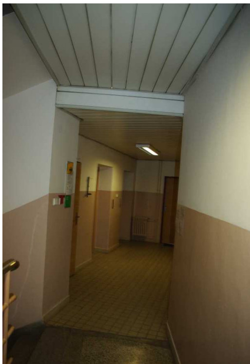
Stávající podhled-chodba u schodiště
